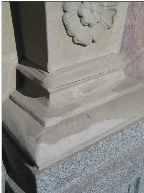
Bild 6. Färgförändring av lagningsbruk, bruket har med tiden blivit för ljult i förhållande till stenen, detalj av sandstensportal på Strandvägen i Stockholm.
