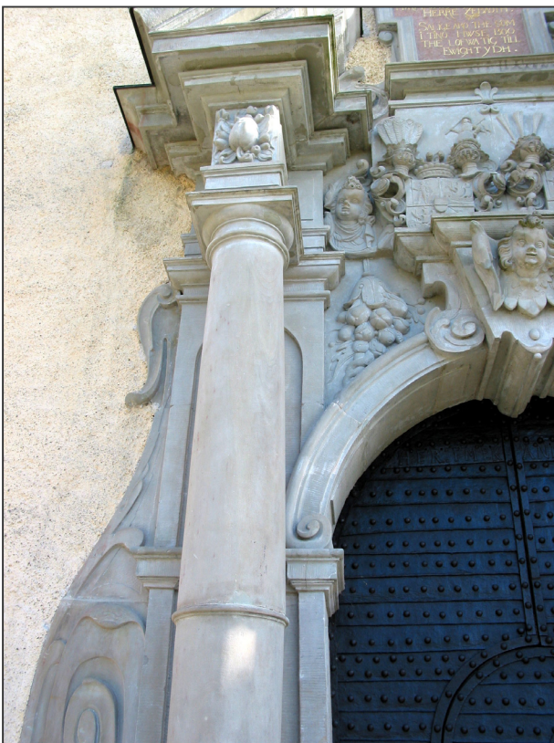
Bild 3. Exempel på mycket långvarig behandlingseffekt, portalen konsoliderades år 1990 och uppvisar inga tecken på vittring eller sandning, Vadsbro kyrkas huvudportal, Södermanland.
