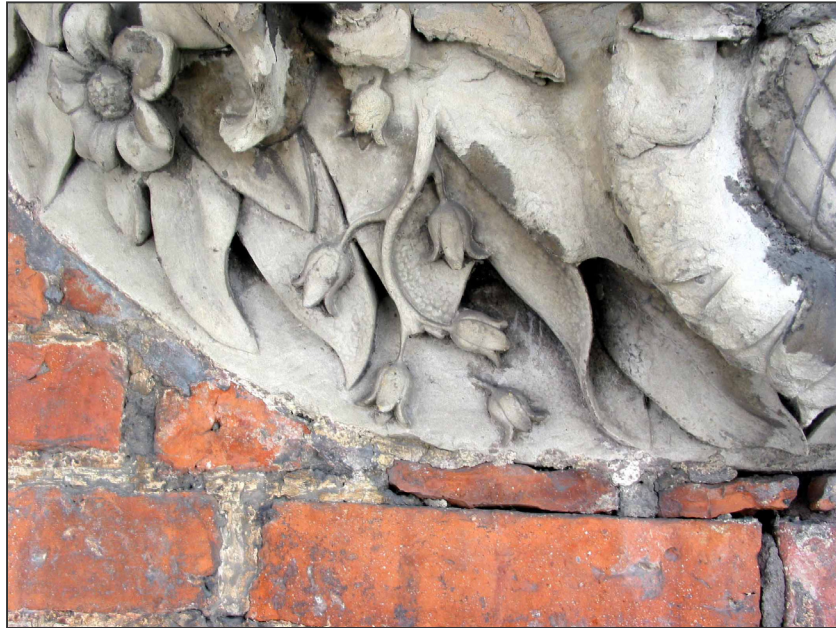
Bild 2. Typisk skadebild gällande gotländsk sandsten, vittring visar sig i form av sandning på ytor utsatta för regn och mörk krusta på regnskyddade ytor, detalj av fasaddekoration, Ridarhuset i Stockholm.
