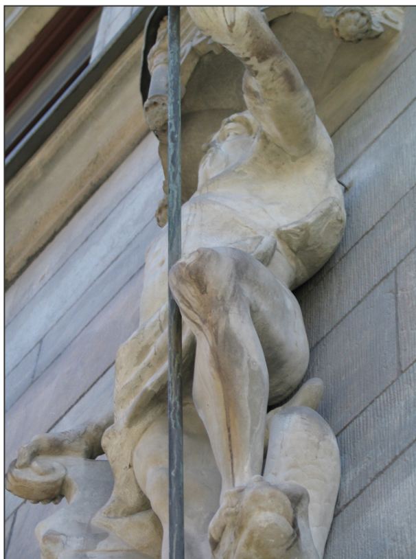
Bild 5. Tydliga spår från vattenavrinning som förknippas med den hydrofoberande behandlingen, Neptunus skulptur, Landbyska verket, Stureplan, Stockholm.
