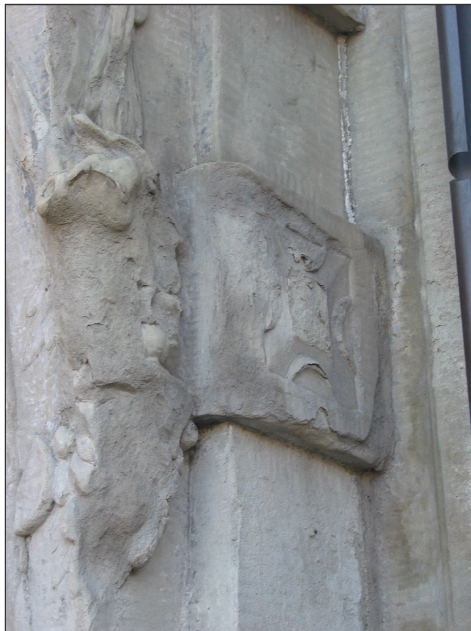
Bild 1. Sandning och exfoliering förändrar stenobjektets uttryck totalt genom att suddat ut skulpterade former, detalj av Petersenska husets dubbelportal, Gamla stan Stockholm.
